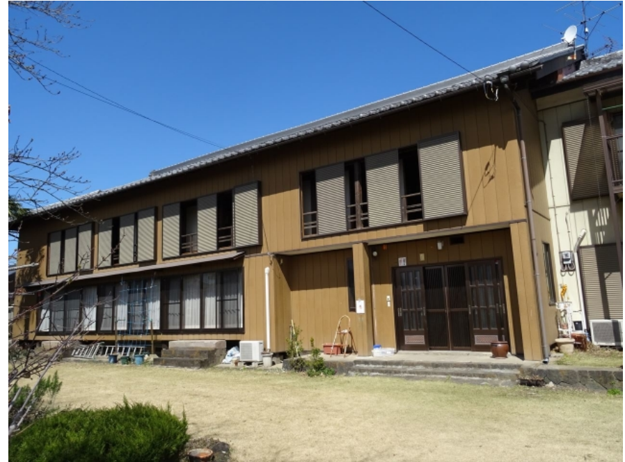
桑麻館 田島武平旧宅(本家)
