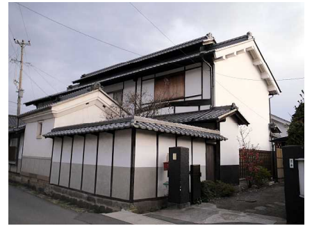
工藤家母屋兼蚕室 653
