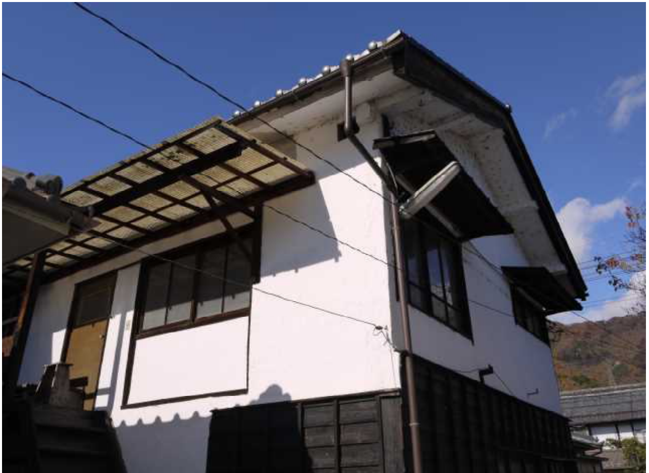
橋詰家の蚕室（気抜き改作撤去） 731
