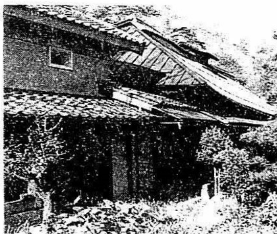
第3図 滝沢章蔵家 茅葺き屋根に気抜きを付け養蚕（昭和63年撮影）
